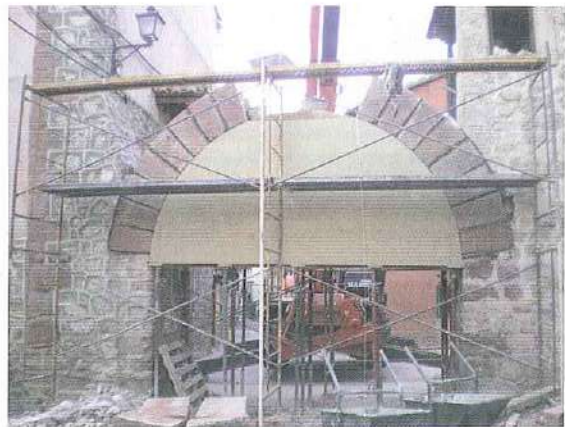
“Reconstrucción arco en Gea de Albarracín. Año 2010”
